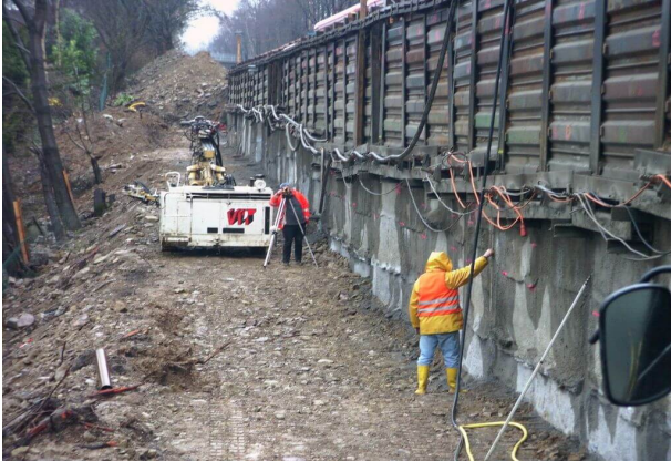
<p>Erstellung der Hangsicherung mit Spritzbeton</p>
