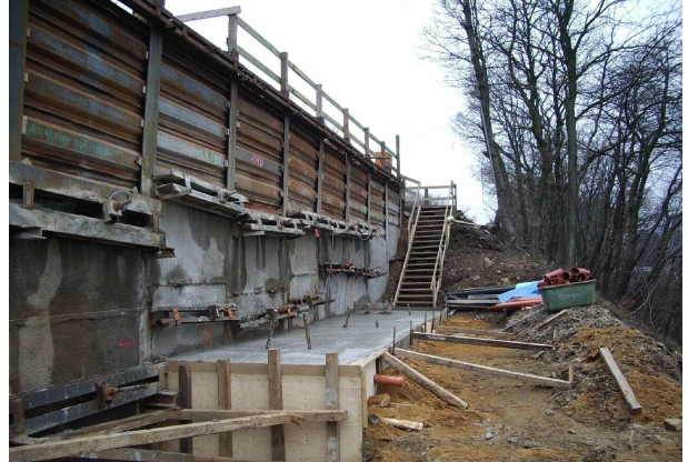
<p>Fundamente der Stützwände</p>
