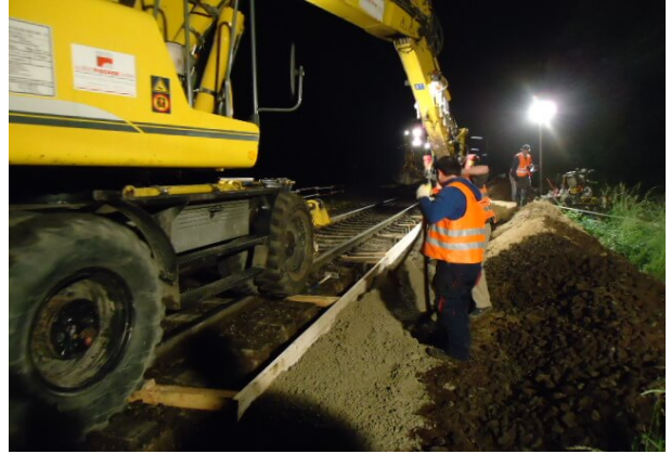
Einbau Bahnsteigkanten
