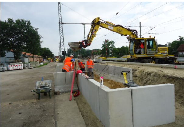
Herstellung Rampenanlage Gleis 3
