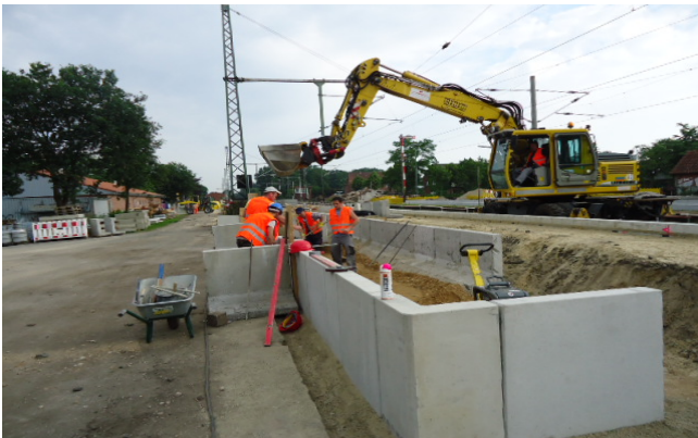
Herstellung Rampenanlage Gleis 3
