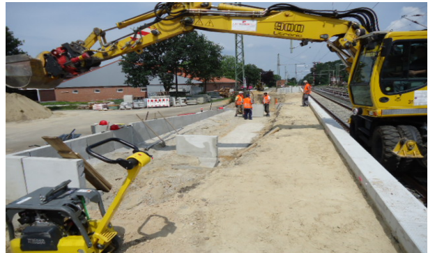
Bahnsteigbau am Gleis 3
