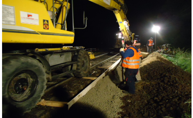
Einbau Bahnsteigkanten
