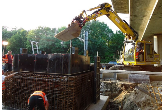
Bau der Aufzugunterfahrt
