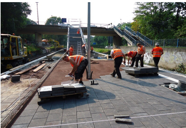
Pflasterarbeiten auf dem Mittelbahnsteig
