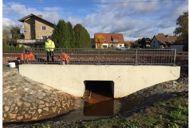
Ansicht fertiggestellter Durchlass
