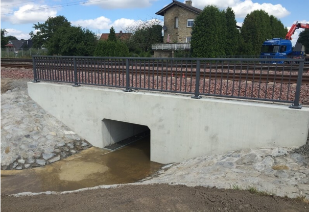
Ansicht fertiggestellter Durchlass
