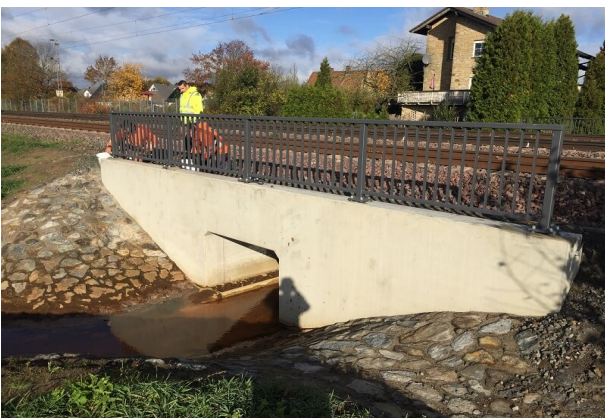
Ansicht fertiggestellter Durchlass
