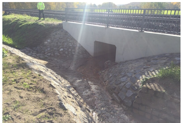
Ansicht fertiggestellter Durchlass
