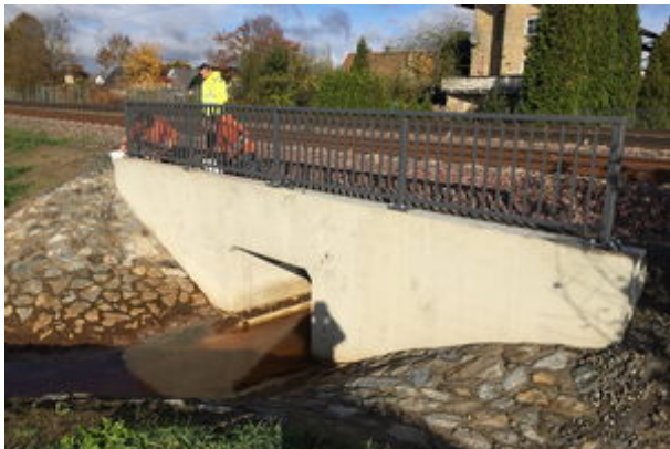
Ansicht fertiggestellter Durchlass
