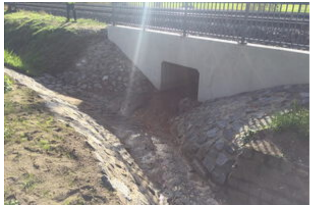
Ansicht fertiggestellter Durchlass
