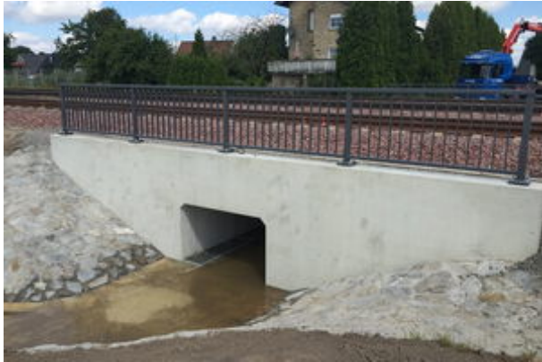
Ansicht fertiggestellter Durchlass
