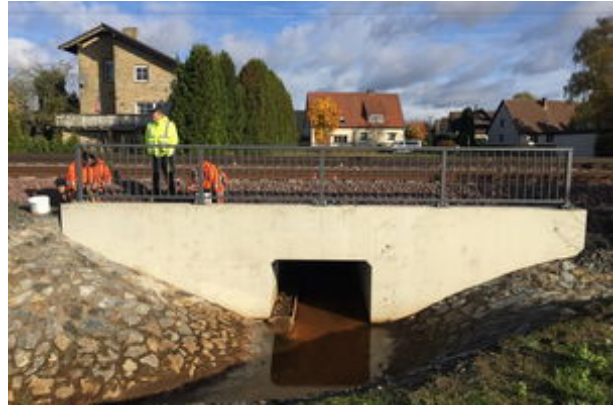
Ansicht fertiggestellter Durchlass
