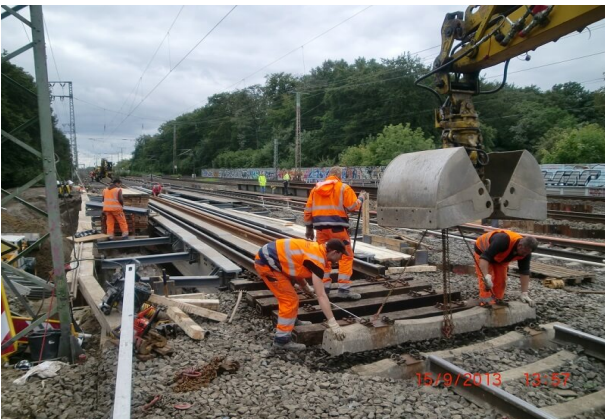
Herstellung Lückenschluss nach Hilfsbrückeneinbau
