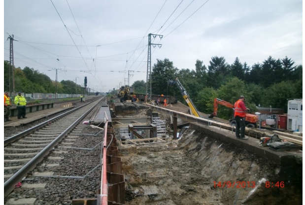
Nachschiessen der Rammtrichterichtung Stützenturm für die Mittelunterstützung der Auflager der Hilfsbrücke
