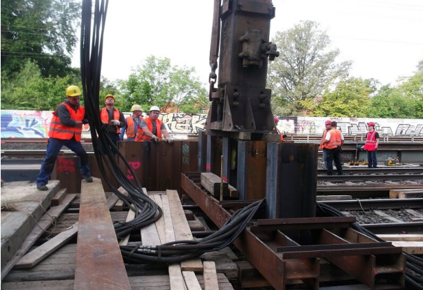
Nachschiessen der Rammtrichterichtung Stützenturm für die Mittelunterstützung der Auflager der Hilfsbrücke
