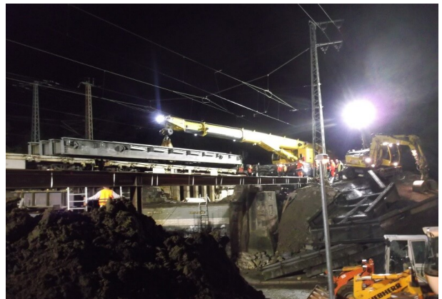
Einhub der Hilfsbrücke in nächtlicher Sperrpause
