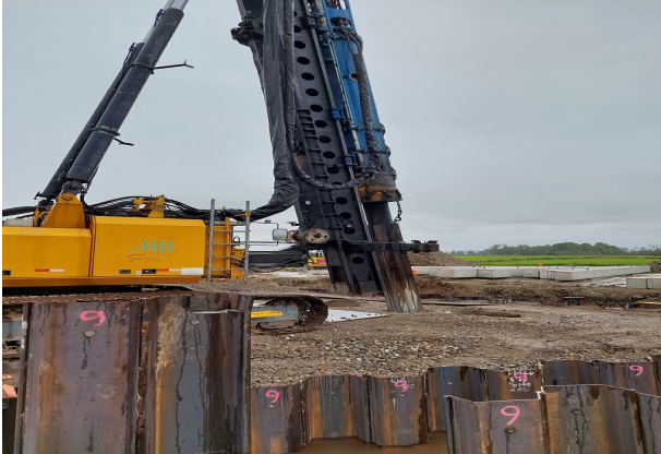
Gründungsarbeiten für die neuen Widerlager mit Stahlbetonrammpfählen
