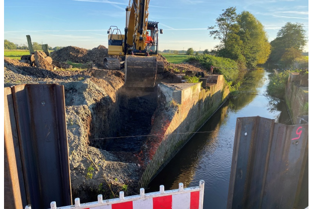
Freilegung und Abbruch der alten Brückenwiderlager
