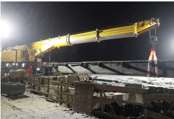
Einbau der Gleishilfsbrücke mit Schienenkran
