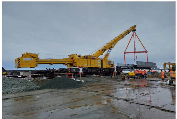
Einbau des neuen Stahlüberbaus mit Schienenkran
