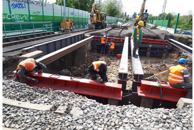
Einbau Auflagerträger
