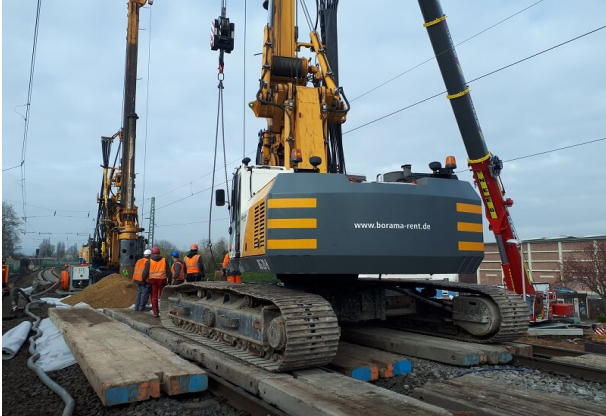
Bohrarbeiten, Länge 18 m
