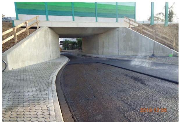
Straßenbauarbeiten im Bereich Rahmenbauwerk
