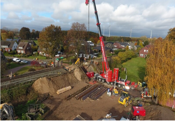
Ansicht der Baustelle aus der Vogelperspektive
