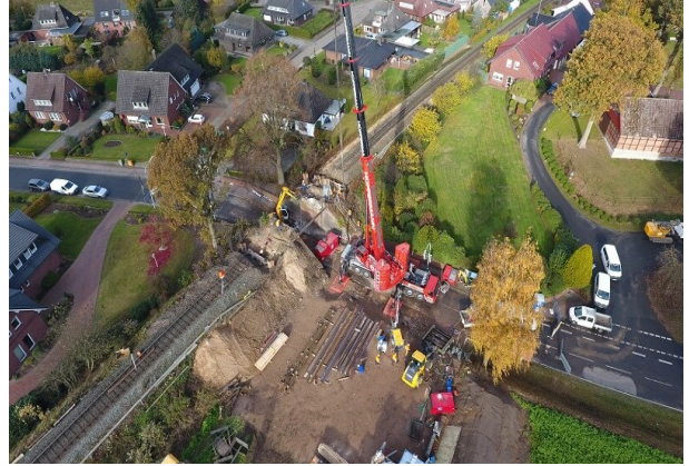
Ansicht der Baustelle aus der Vogelperspektive
