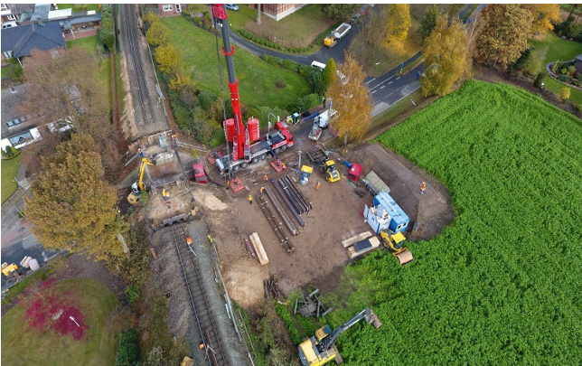
Ansicht der Baustelle aus der Vogelperspektive
