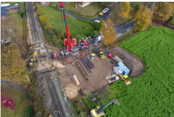
Ansicht der Baustelle aus der Vogelperspektive
