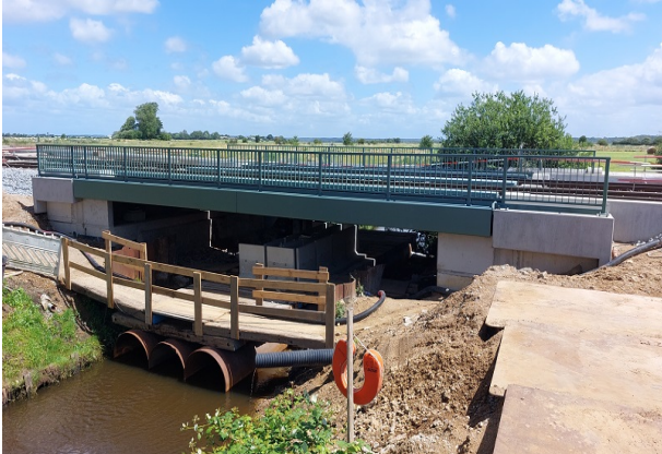
Einbau der neuen Überbauten inklusive Geländer
