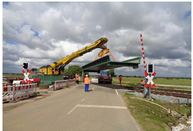
Aufnahme des neuen Stahlüberbaus vom Schwerlasttieflader
