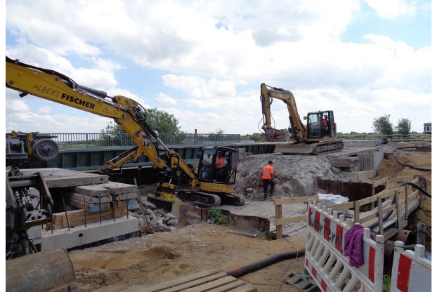
Stemmarbeiten im verrohrten Bachbett
