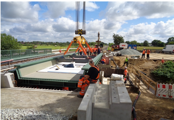
Einhub der neuen Dickblechtragbrücke
