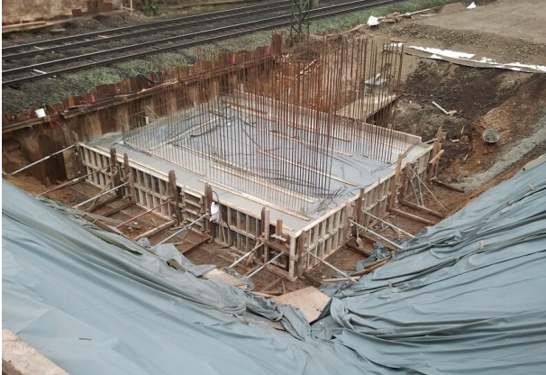
Fundament Widerlager B
