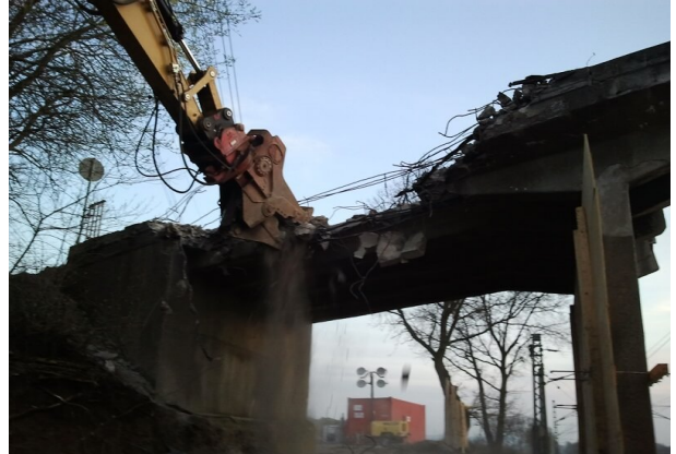
Abbruch der alten SÜ
