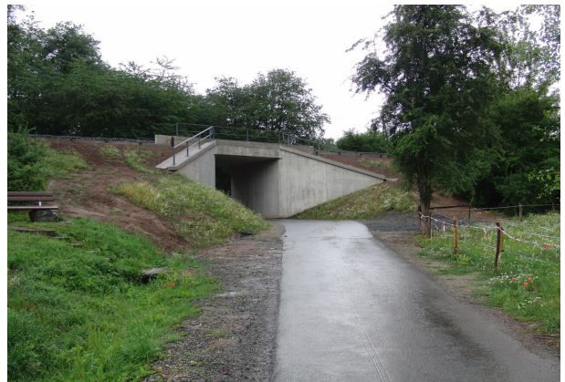
<p>Fertiges Bauwerk nach Inbetriebnahme</p>
