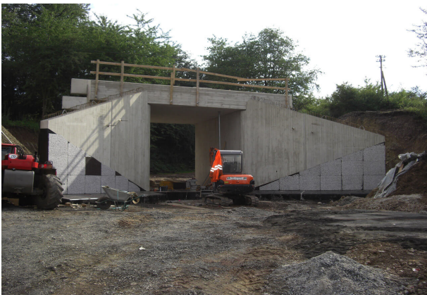
<p>Bauwerk nach Einschub</p>
