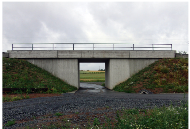
<p>Fertiges Bauwerk nach Inbetriebnahme</p>
