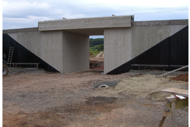
<p>Brücke/Fertigteile nach Verschub</p>
