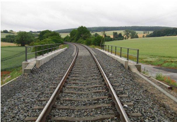
<p>Fertiges Bauwerk nach Inbetriebnahme</p>
