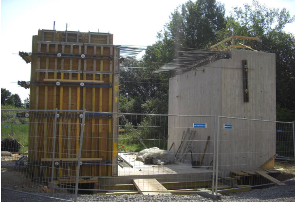
<p>Herstellung des Rahmens in Seitenlage</p>
