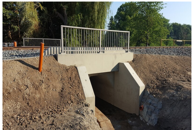
Rahmenbauwerk Ansicht Auslauf
