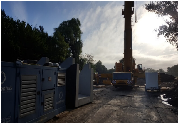
Mobilkran zum Einheben der Fertigteile
