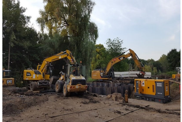
Maschineller Aushub im Verbaukasten
