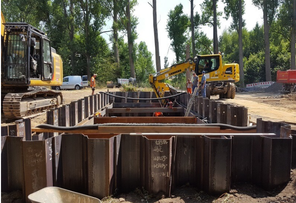
Maschineller Aushub im Verbaukasten
