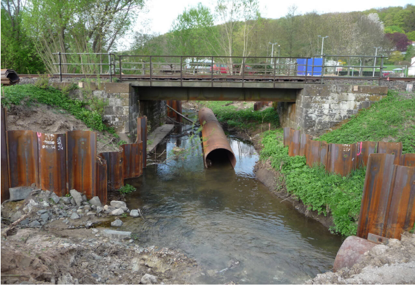
<p>Vorhandenes Bauwerk vor Umbau</p>
