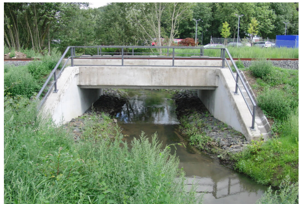
<p>Fertiges Bauwerk nach Inbetriebnahme</p>
