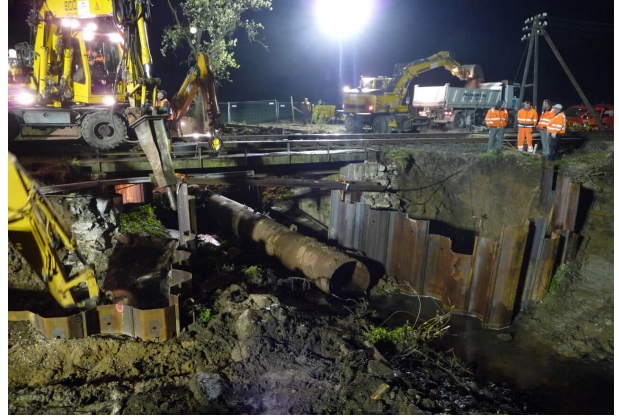
<p>Abbruch der vorhandenen Eisenbahnüberführung</p>
