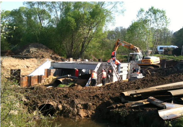
<p>Nach Einbau der Fertigteile</p>
