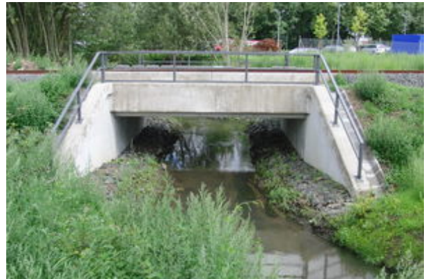
Fertiges Bauwerk nach Inbetriebnahme
