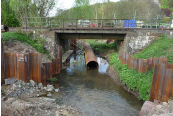
Vorhandenes Bauwerk vor Umbau
