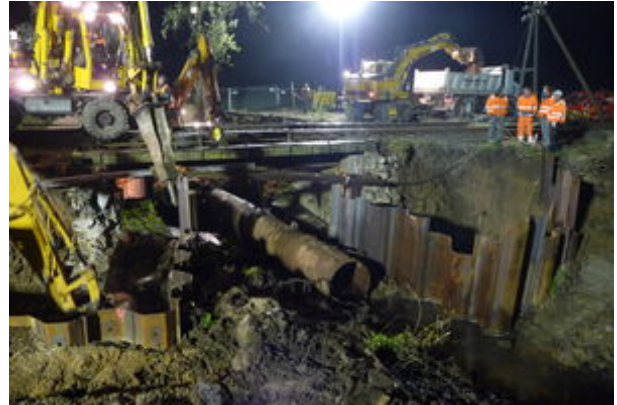
Abbruch der vorhandenen Eisenbahnüberführung
