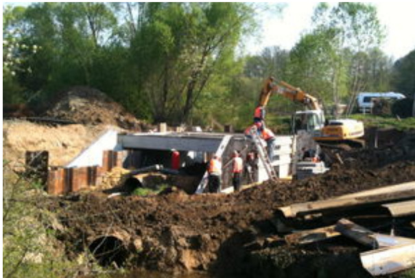
Nach Einbau der Fertigteile
