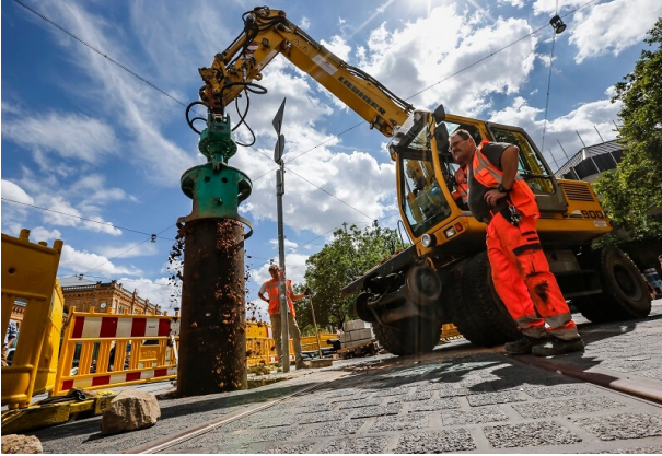
Bodenförderung durch die innenliegende Schnecke
