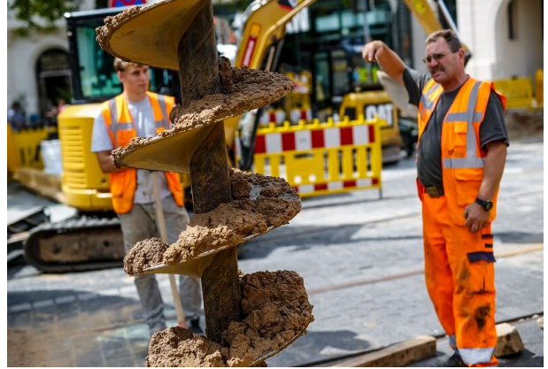
Ausbau der Schnecke aus dem Rohr
