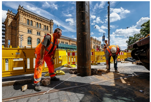
Ausrichten des Rohres während des Einbaus
