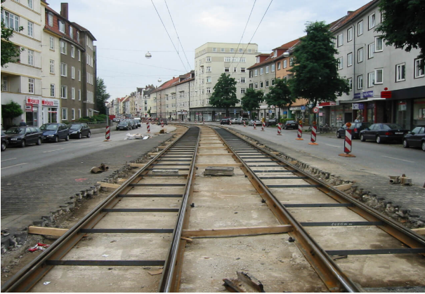
<p>Rillenschienengleis Ri 60 mit provisorischer Kaimulde aus Stahlblech für den Bahnsteig und Einbau der Mineraltragschicht</p>
