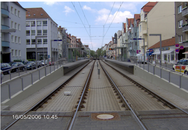
<p>Hochbahnsteig mit Gleis auf Stahlbetonlängsbalken</p><p>Rampe Hammersteinstraße mit Gleis auf Betonchwelle</p>
