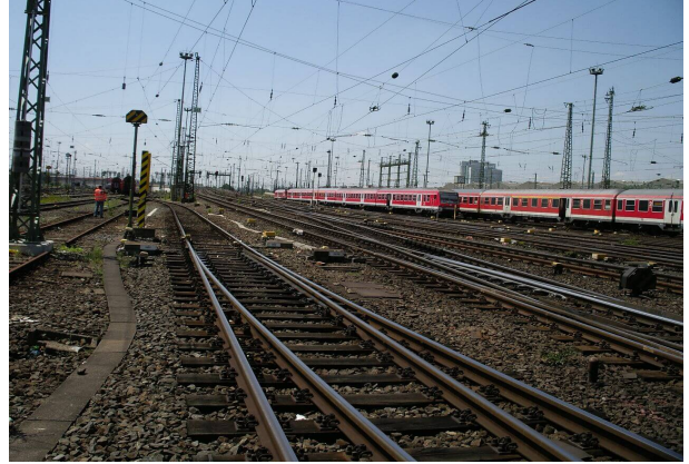
<p>Gleisrampe vor dem Umbau</p>
