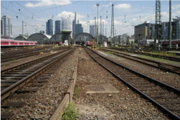
Gleisabschnitt „Bebraer Einfahrt“ in den Hbf
