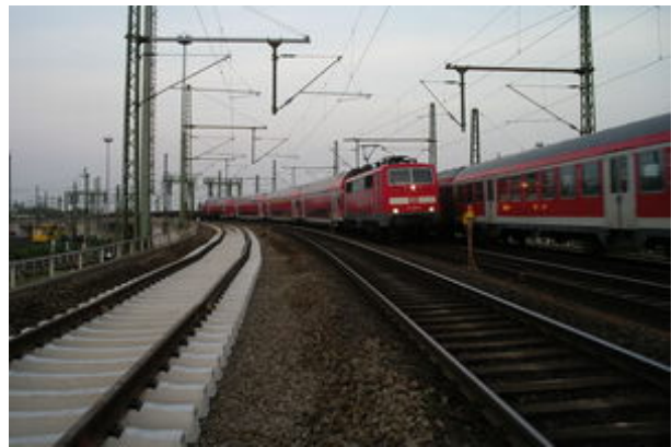
Auf dem Schotterplanum verlegtes Gleis
