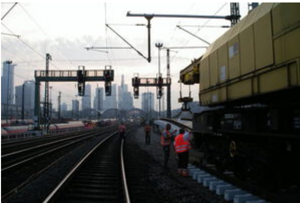
Verlegen der vormontierten Gleisjoche mit Kran
