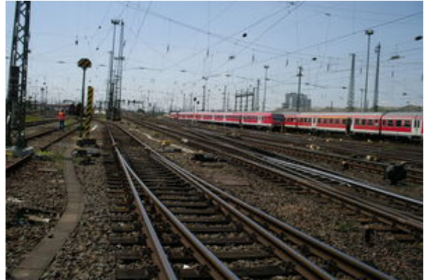
Gleisrampe vor dem Umbau
