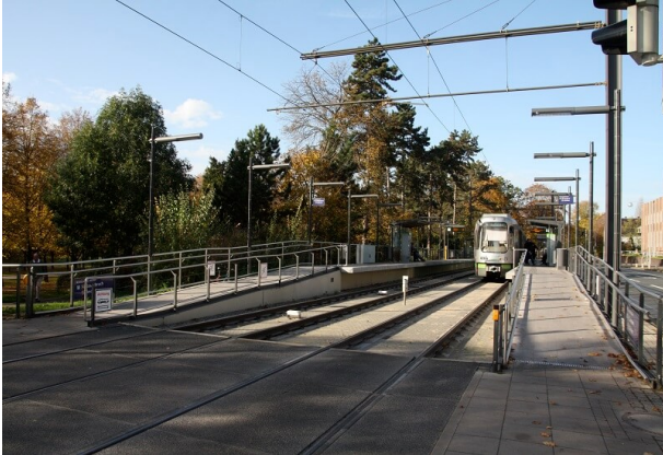
Bahnübergang mit Bahnsteigrampen
