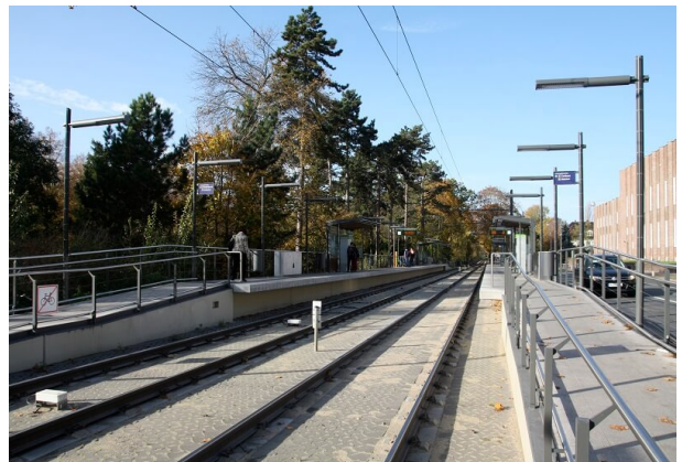
Längsbalkengleis in Haltestelle
