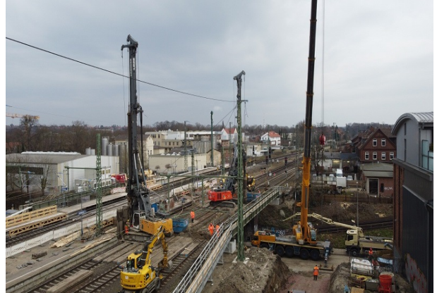
Herstellung der Gründungspfähle für die Gleishilfsbrücken Gleis 203-205
