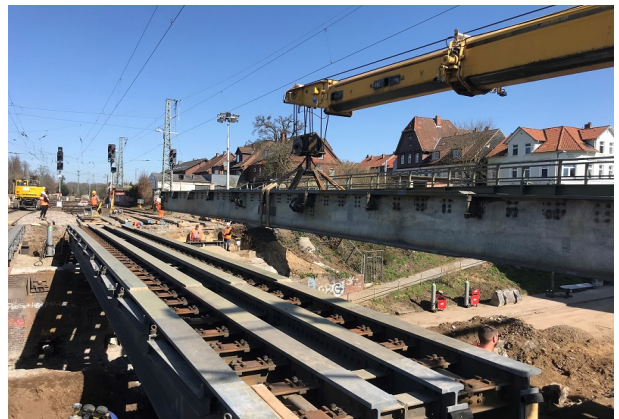
Einbau Gleishilfsbrücke mit EDK im Gleis 205
