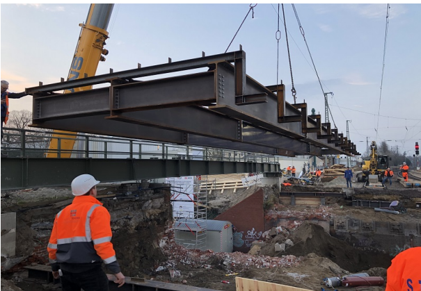
Einbau Bahnsteighilfsbrücke am Gleis 201
