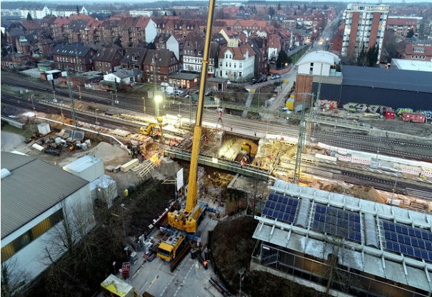
Luftbild vor Einbau der Gleishilfsbrücken Gleis 201 + 202 am Bf Lüneburg
