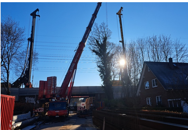
Aufgebaute Bohrgeräte auf dem Bahndamm
