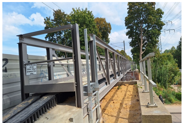
Kabelhilfsbrücke einschließlich Anrampung
