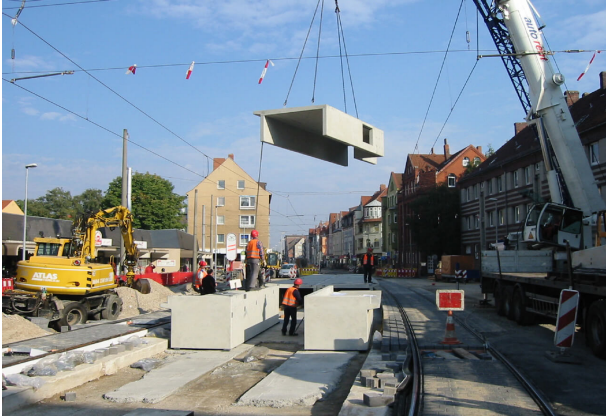
<p>Versetzen der Stahlbetonfertigteile</p>
