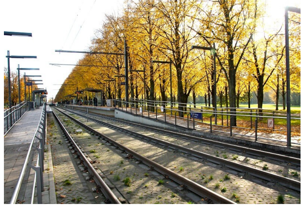
Ansicht der Rampen
