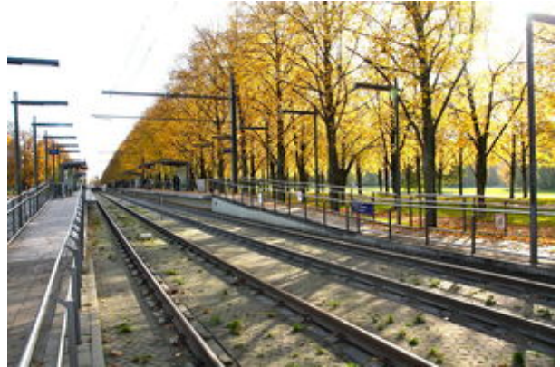
Ansicht der Rampen
