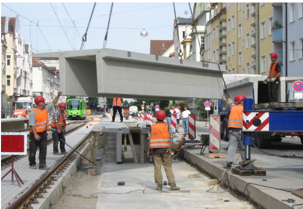
>Versetzen der Stahlbetonfertigteile am Hochbahnsteig Lortzingstraße</p><p>Hochbahnsteig Lortzingstraße</p>
