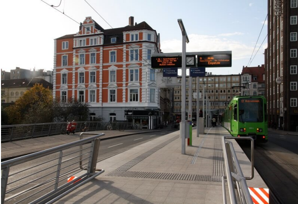
Übergang Rampe / Bahnsteig
