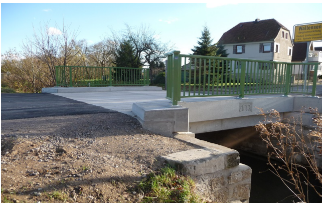
Ansicht der fertiggestellten Brücke
