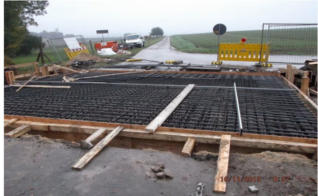
Bewehrung der Stahlbetonfahrbahn
