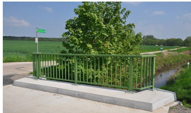
Ansicht der fertiggestellten Brücke
