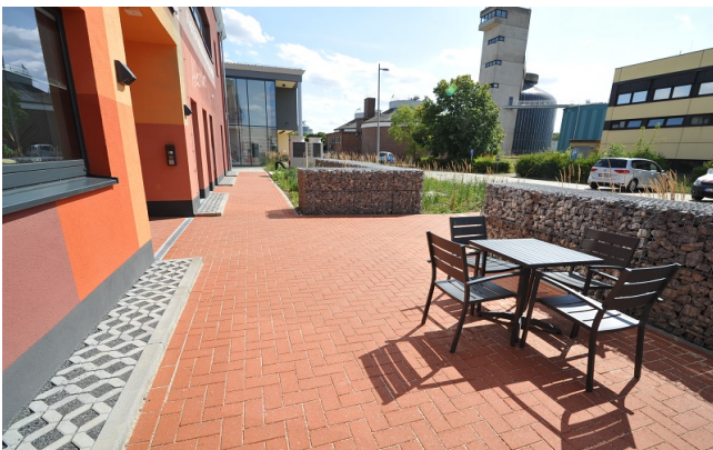
Ansicht Pflasterfläche Eingang und Gabionen
