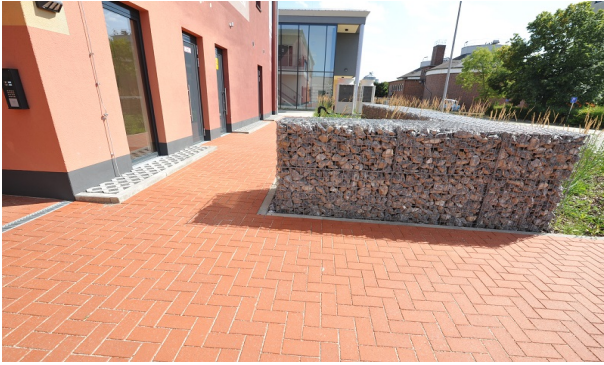
Ansicht Pflasterfläche und Gabionen
