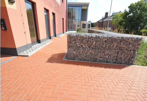
Ansicht Pflasterfläche und Gabionen
