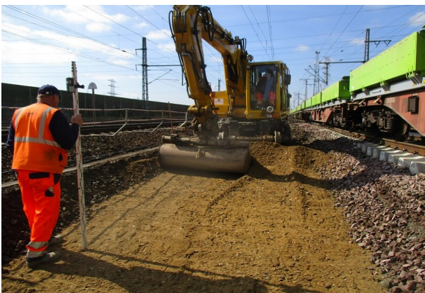
Einbau der Frostschuttschicht
