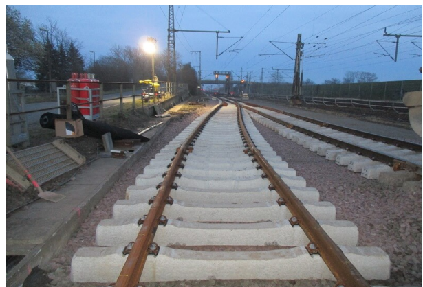
Verlegte Weichen mit Anschlusslängen
