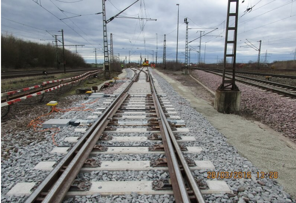
Fertig eingebaute Weichen mit Anschlusslängen
