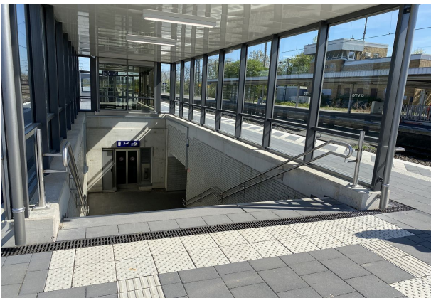
Fertiggestellte Einhausung Treppenabgang Mittelbahnsteig
