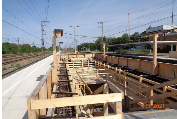
Schalung + Bewehrung Treppenwandkopf Mittelbahnsteig
