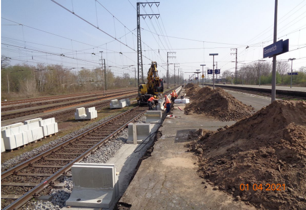
Einbau Bahnsteigkantenfertigteile am Gleis 4
