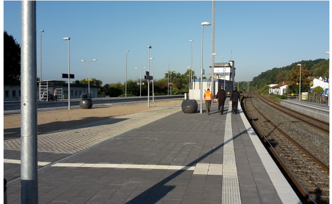
Ansicht Innenfläche Bahnsteig 1 / 11
