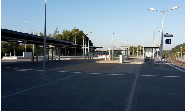
Ansicht Innenfläche Bahnsteig 1 / 11
