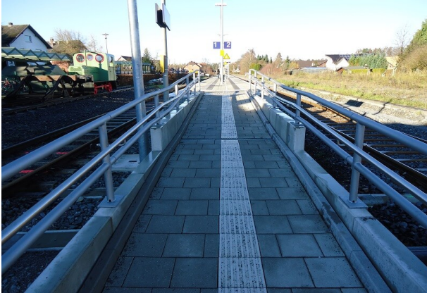
Zuwegung zum Bahnsteig Gleis 1+2
