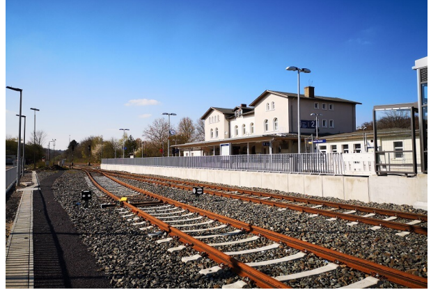
Süd-Ost-Ansicht, Haus- und Mittelbahnsteig sowie Treppenaufgang zur Mittelbahnsteiganlage, Blick auf die neuen Gleise 5 und 6 sowie Winkelstützwand Mittelbahnsteig
