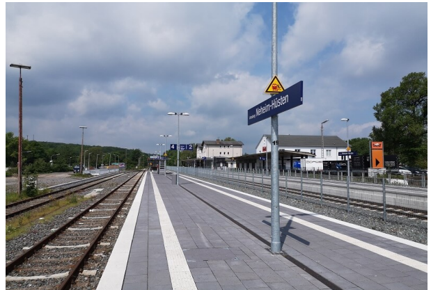
Mittelbahnsteig mit Querungsbarriere, Hausbahnsteig
