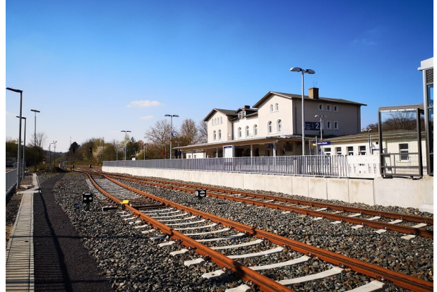
Blick vom Mittelbahnsteig auf die neuen Gleise 5 und 6 sowie Winkelstützwand Mittelbahnsteig
