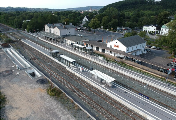
Süd-Ost-Ansicht, Haus- und Mittelbahnsteig sowie Treppen- und Rampenanlage
