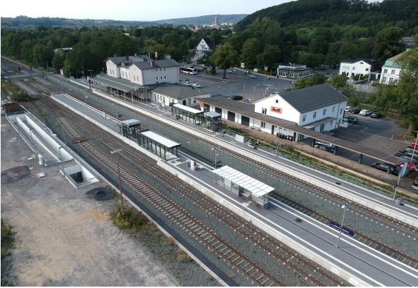
Süd-Ost-Ansicht, Haus- und Mittelbahnsteig sowie Treppenaufgang zur Mittelbahnsteiganlage, Blick auf die neuen Gleise 5 und 6 sowie Winkelstützwand Mittelbahnsteig
