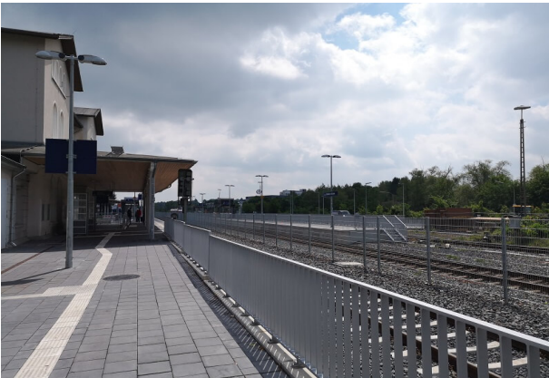
Zuwegung zum Bahnsteig, Blick auf Bahnsteigdach, Haus- und Mittelbahnsteig
