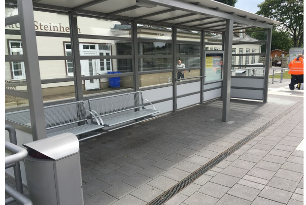
Wetterschutzhaus TSI konform Gleis 1
