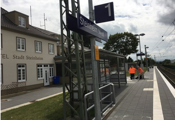
Wetterschutzhaus am Gleis 1
