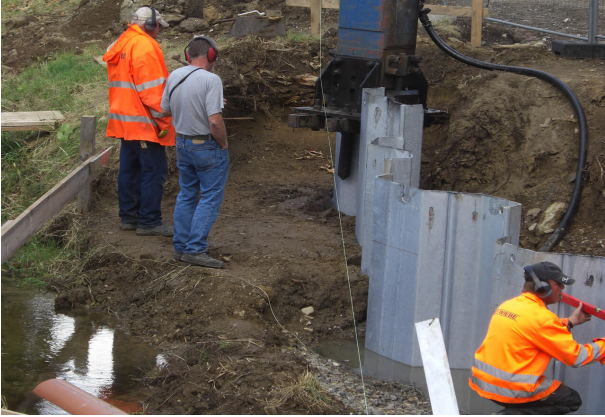
<p>Gründung der Widerlager auf Spundwänden</p>
