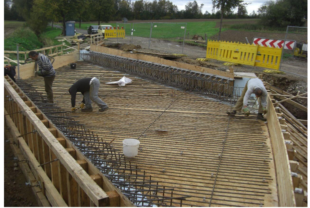
<p>Stahlbetonarbeiten an dem Überbau</p>
