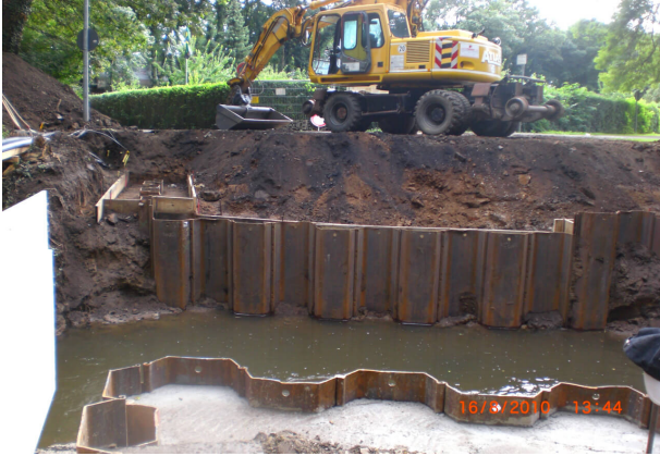
<p>Gründungsarbeiten: Spundwand rammen</p>
