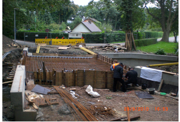
<p>Herstellung der Stützwände und des Überbaus</p>
