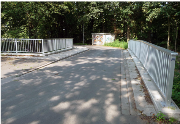
<p>Umfangreiche Erd- und Straßenbauarbeiten</p>
