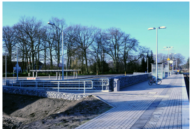
<p>Fertiger Bahnsteig nach Inbetriebnahme</p>
