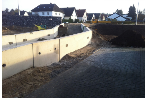
<p>Einbau von Fertigteilen</p>
