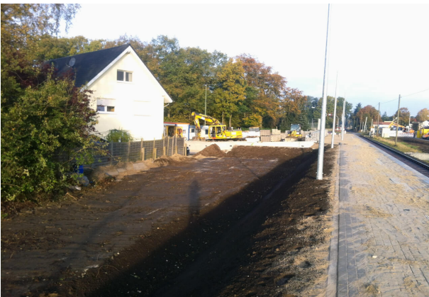
<p>Bahnsteig kurz vor Fertigstellung</p>
