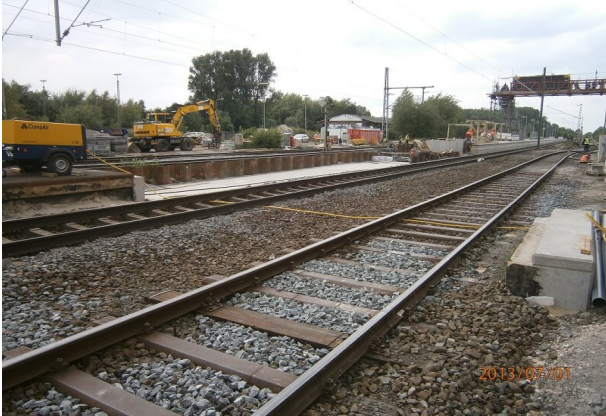
Verbau des Tunnels mit provisorischer Fußgängerüberführung
