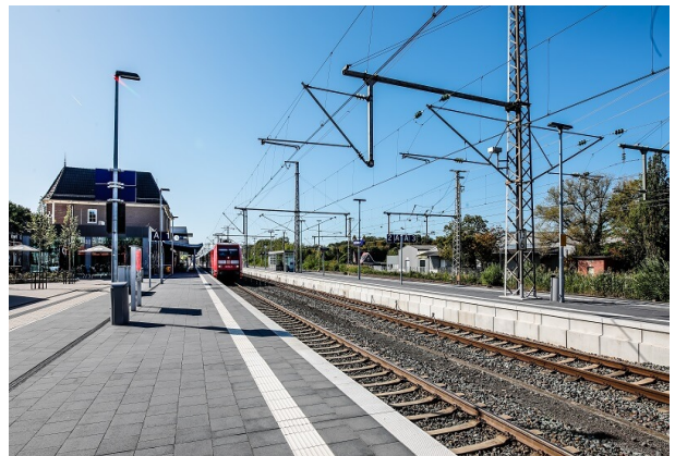
Ansicht Bahnsteig mit taktilem Leitsystem
