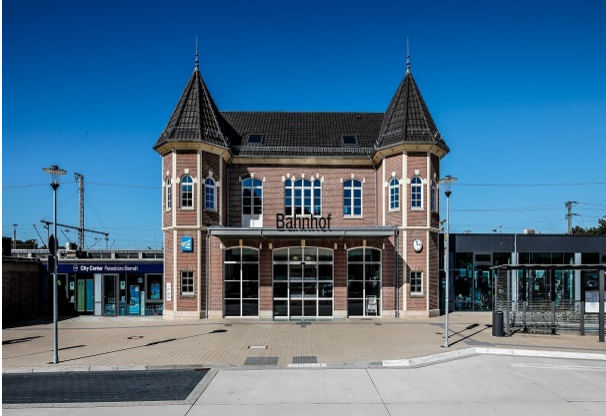
Frontansicht Bahnhof Bad Bentheim
