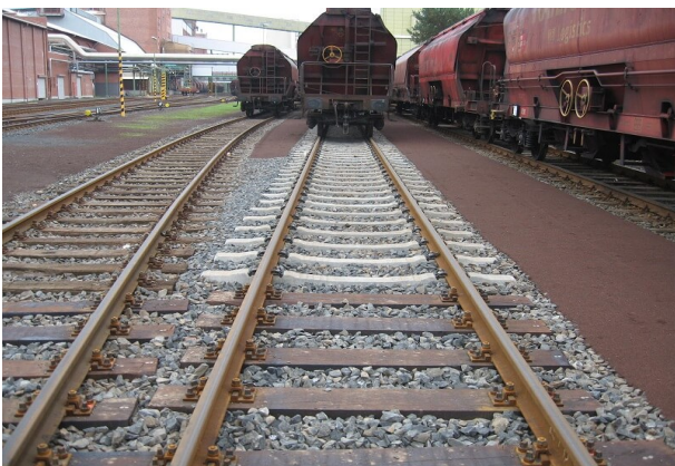
Gleiserneuerung mit Bettungserneuerung
