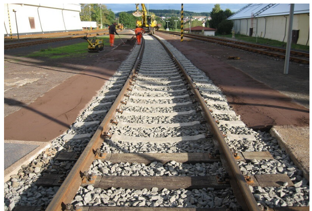
Gleiserneuerung mit Bettungserneuerung
