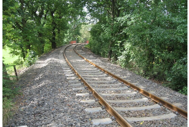
Gleiserneuerung mit Bettungserneuerung
