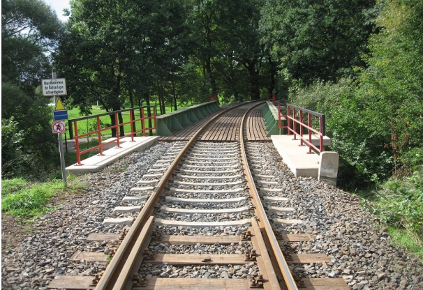
Gleiserneuerung mit Bettungserneuerung.
