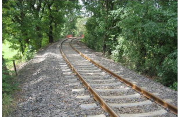
Gleiserneuerung mit Bettungserneuerung
