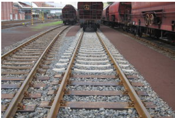
Gleiserneuerung mit Bettungserneuerung
