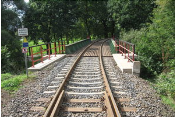
Gleiserneuerung mit Bettungserneuerung.
