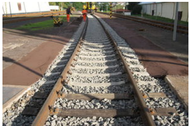
Gleiserneuerung mit Bettungserneuerung
