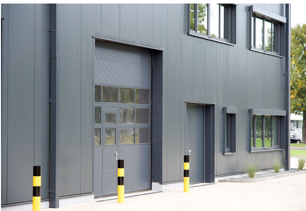
Ansicht fertiggestellte Außenanlagen
