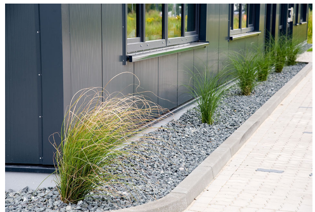
Ansicht fertiggestellte Außenanlagen
