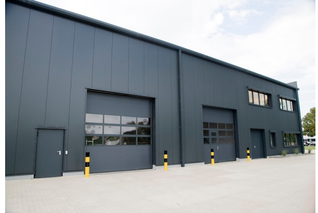
Ansicht fertiggestellte Außenanlagen
