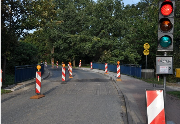
Instandsetzung der Fahrbahn und des Radweges
