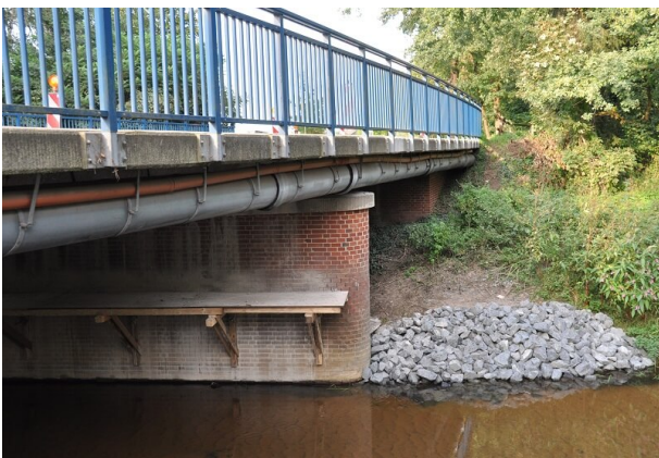
Reparatur der Brücke und der Ufersicherung
