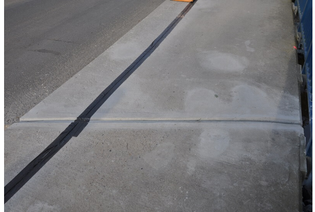
Beton- und Fugensanierung der Randkappen
