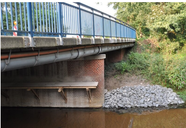
Reparatur der Brücke und der Ufersicherung
