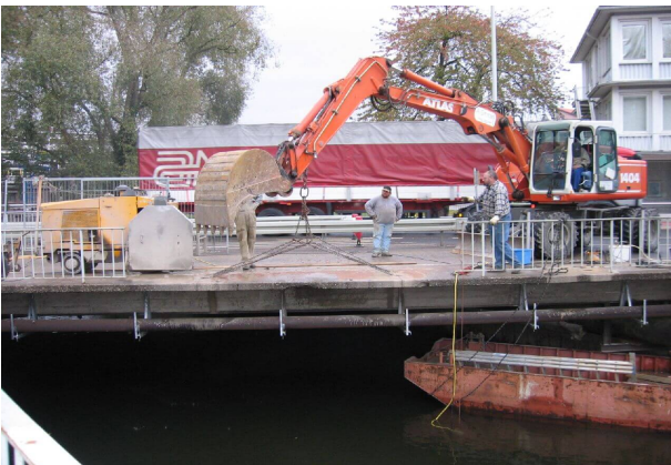
<p>Demontage der vorhandenen Brücke</p>
