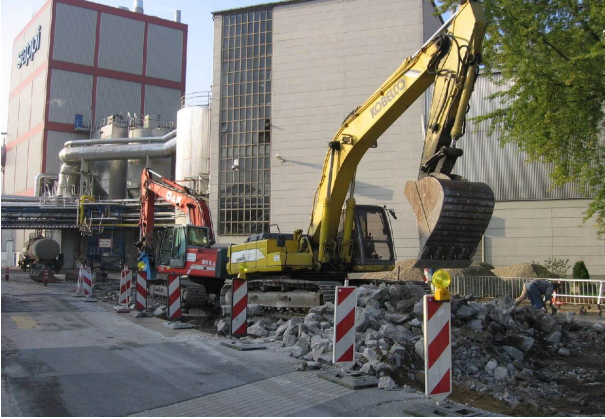
<p>Abbruch der vorhandenen Betonfahrbahn</p>
