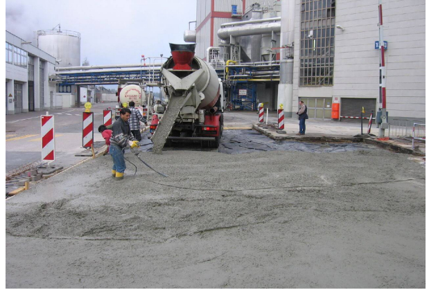
<p>Einbau Straßenbeton mit neuer Gefällesituation</p>
