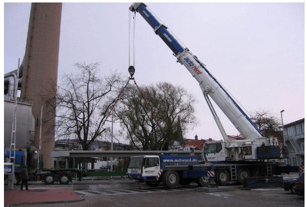
<p>Einbau der neuen Fußgängerbrücke</p>
