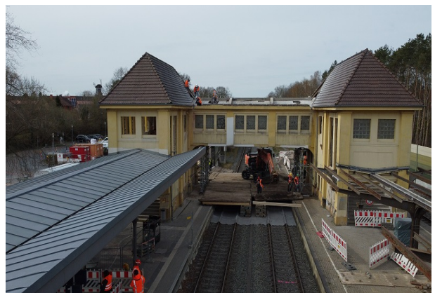
Abriss alte FÜ
