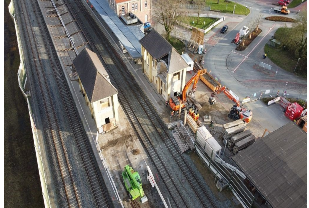
Ansicht von oben Abriss alte FÜ
