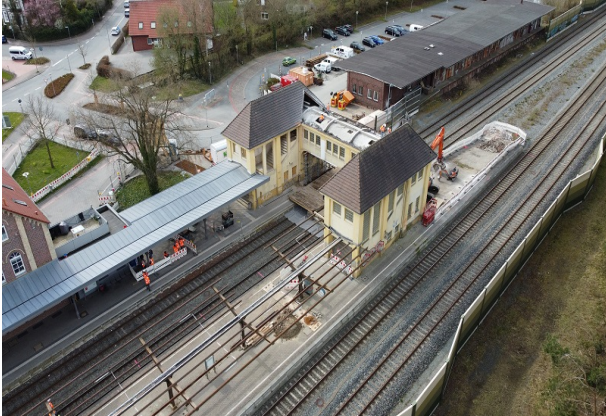
Ansicht von oben Abriss alte FÜ
